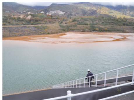
松尾中和処理施設の貯泥ダム Sludge dam, Matsuo neutralization plant
