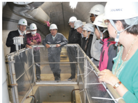
旧坑道から湧出する酸性水の排水路トンネル Drainage tunnel of acidic water seeping through the old mine drifts
