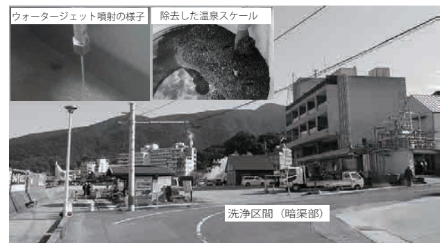
図4 温泉配管スケールのウォータージェット除去実証実験の様子
