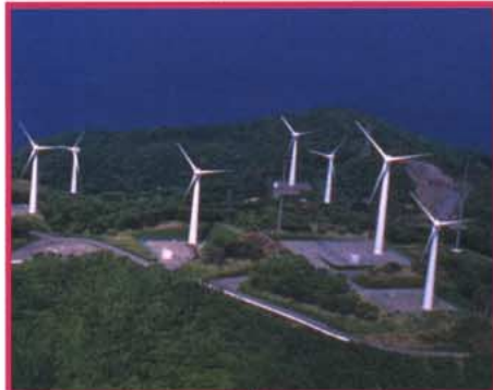
風力発電/For Energy
