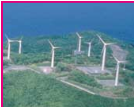
風力発電 / For Energy
