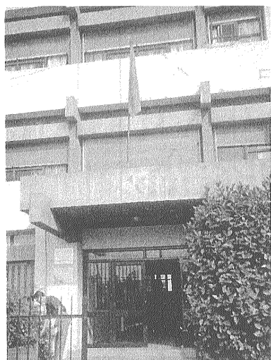
写真1 首都ラバトにあるBRPM探査局の外観。
