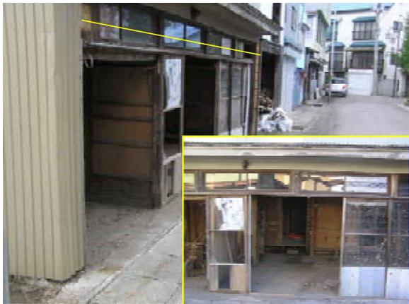
写真-4 下川原地先(図-4中の薄い網掛け部分)での浸水痕跡例(上段:浸水位 0.29 m, 浸水深 2.08 m, 中段: 0.12 m, 2.16 m, 下段: 0.05 m, 2.05 m)
