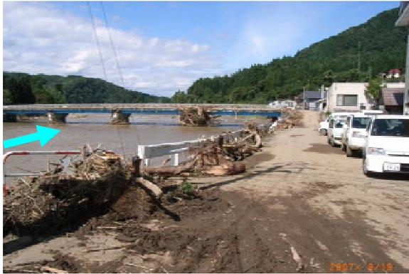
写真-6 八幡橋の右岸側で漂流物がより多く引っかった状況（国土交通省東北地方建設局森吉山ダム工事事務所提供）
