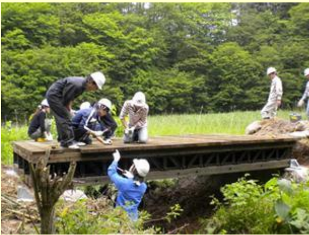
オンサイト木橋の施工
