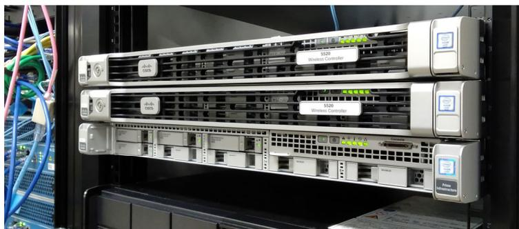
図2 無線 LAN コントローラ Cisco WLC552
