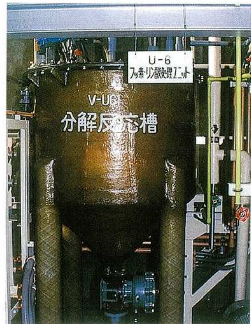
写真4 フッ素・リン酸系廃液反応槽
